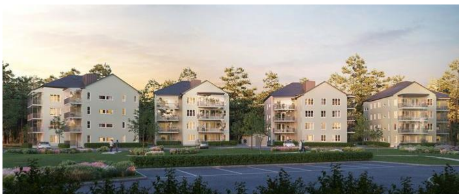
Figur 6. Nybyggnation Sanatorieskogen (Lejons mäklari, 2021)
