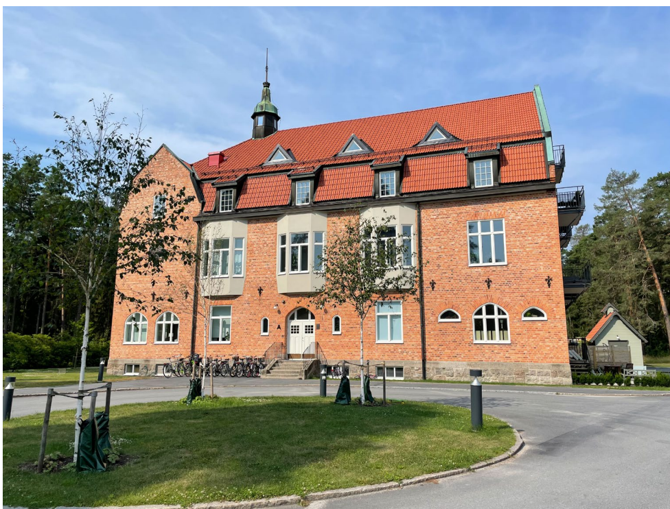
Sanatoriebyggnaden uppförd 1908-1912 efter ritningar av Magnus Dablander som var stadsarkitekt.
