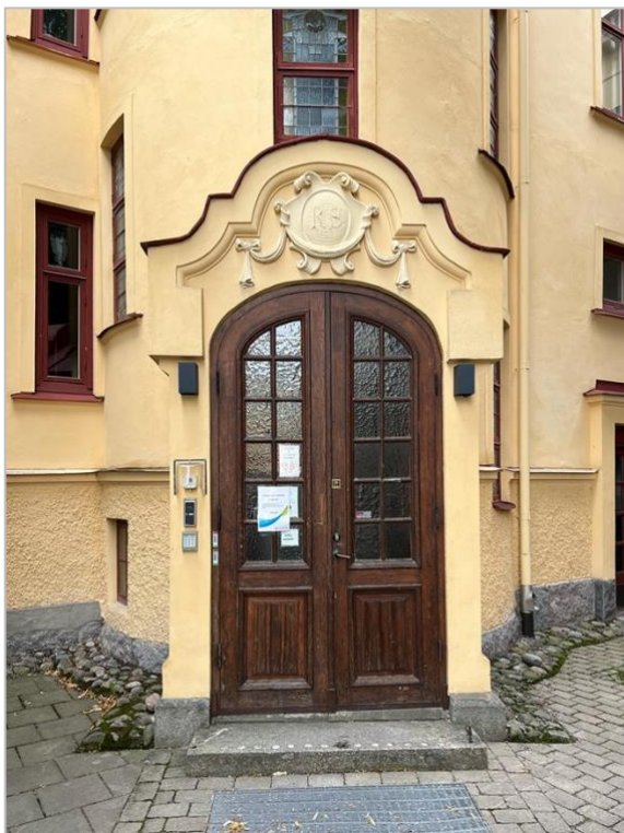
Ett exempel på bevarade ursprungliga byggnadsdetaljer på Rustmästaren 1. Här är entréporten, fönstren, balkongerna och de dekorativa fasadelementen bevarade.
