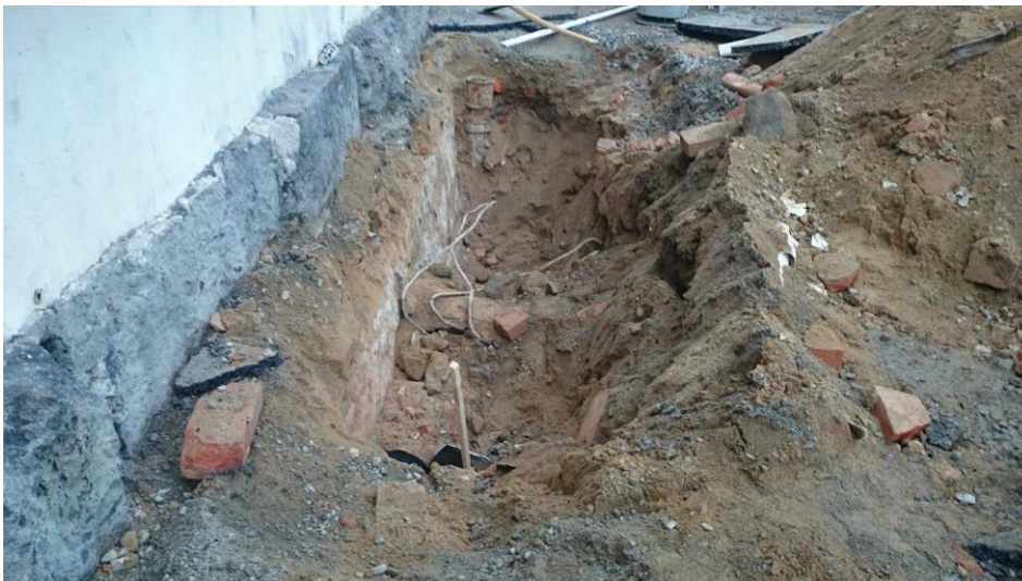
Bild 3; Provgrop PG2 inom Fåfängan 1 i direkt anslutning till befintlig byggnad inom Fåfängan 10. Stora mängder rivningsrester såsom tegel och armering. Stakkäppen markerar ett påträffat kärl med hydraulolja som nu avlägsnats. Notera att delar av väggen från tidigare byggnad fortfarande finns kvar.
