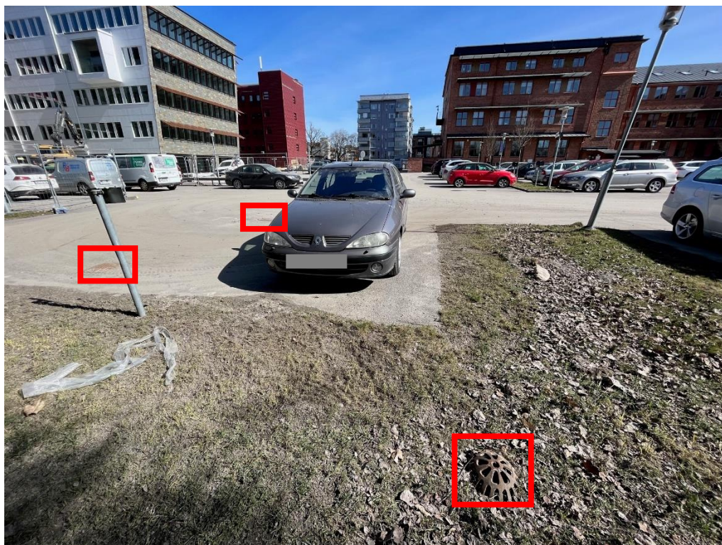
Figur 19 - Galler och kupolbrunn (röd), Kexfabriken 3 västra delen (Platsbesök 2023-04-20).
