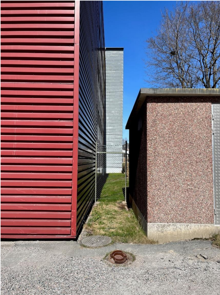
Figur 16 - Dagvattenbrunn i Kexfabriken 2 östra del, mellan byggnader (Platsbesök 2023-04-20).
