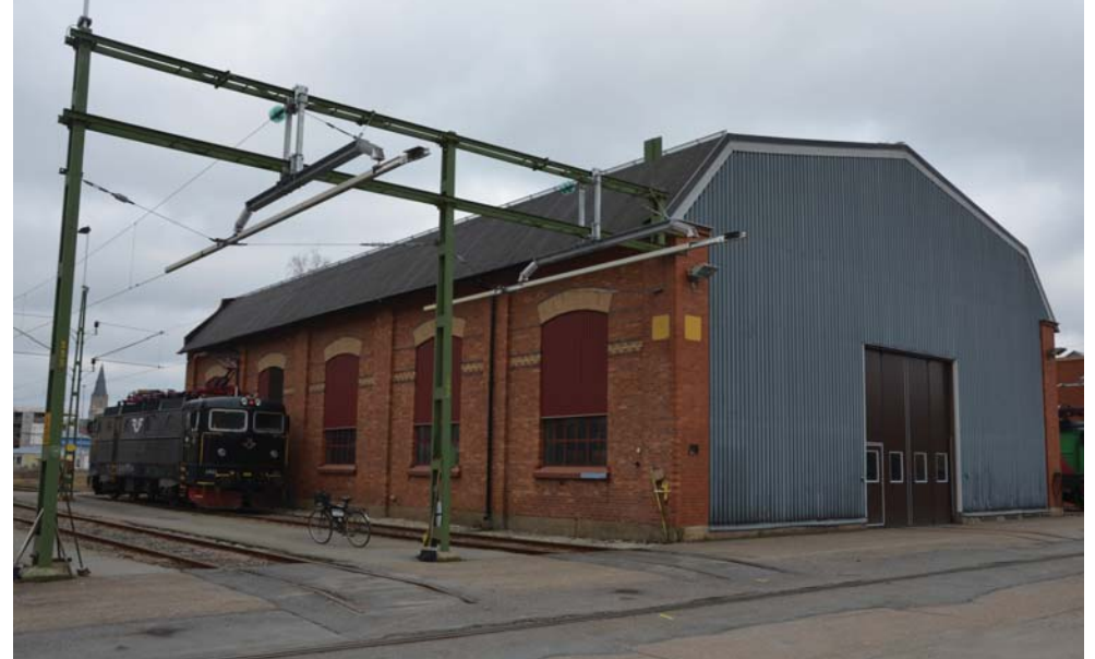
Spårharpan utmed komponentförrådets södra fasad. Foto 2017
