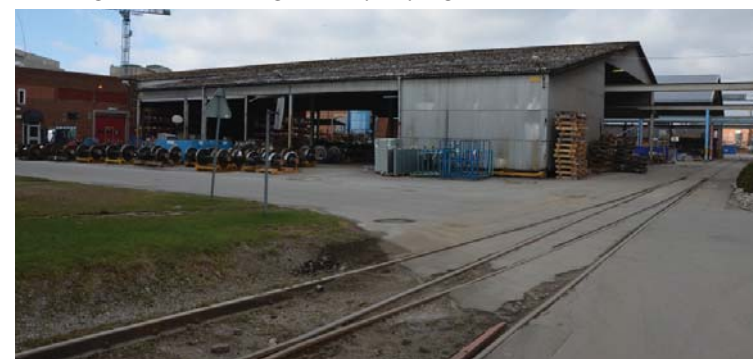
Skärmtak som hör till byggnaden "Kontor och plåtförråd". Foto 2017
