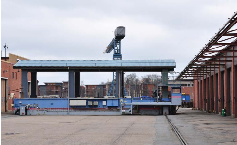
Marktraversen löper längs med lokverkstadens västra fasad och spår finns fram till varje port. Foto 2017
