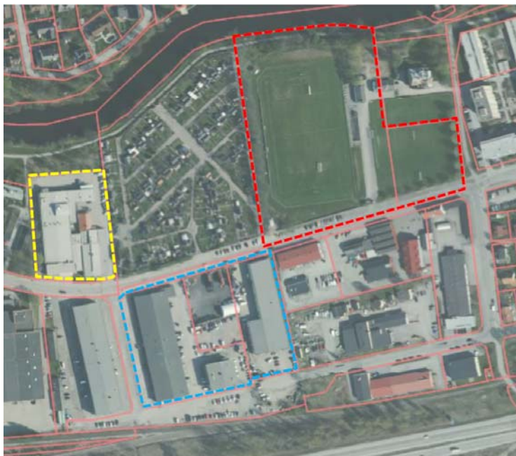
Figur 3.2 Flygfoto över Örnsro industriområde (orebro.se), där detaljplaneområdet är markerat med rött, fastigheten Tjänstemannen 2 med gult och Träsnidaren 2 och 4 med blått.
