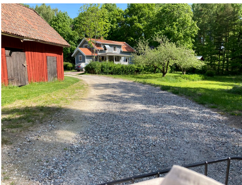
Befintligt bus som ligger väster om planområdet.
