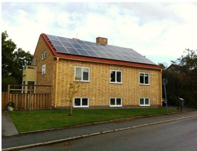
Figur 7. Installerad solelanläggning som beviljats bygglov.
