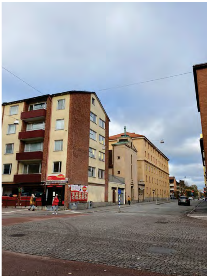
Bild som visar flerbostadshuset och kyrkobyggnaden i korsningen Skolgatan/Järnvägsgatan år 2023.
