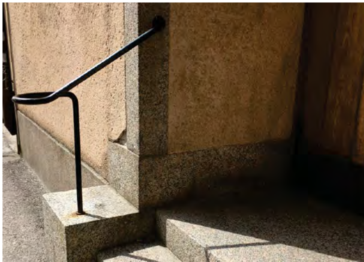
Vid kyrkans entré finns ursprungliga material som trappsteg i granit och räcke i svartmålat smide.
