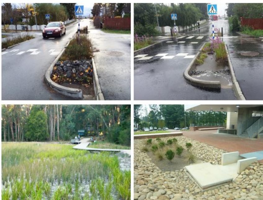
Figur 32. Dagvattenbiofilter i olika miljöer och storlekar i Sverige (Tyresö, med yta för sedimentation), Melbourne, Australien och Raleigh, North Carolina, USA. Foto övre rad till höger: Bertil Eriksson (Svenskt Vatten Utveckling, 2016).
