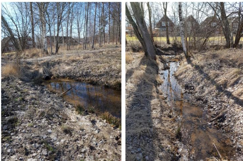
Figur 23. Bild G (t.v.) Vägtrumma under en grusväg norr om Björkhaga bostadsområde. Bild H (t.h.) Dike söder om grusvägen, som avleder vatten mot ett korsande större dike. Det större diket avvattnas i sin tur mot Älvtomtabäcken.
