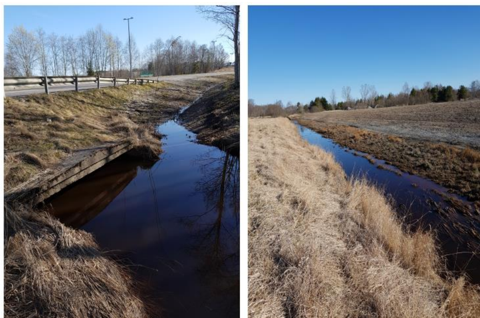
Figur 21. Bild C (t.v.) Kulvert under Sandbackavägen där Älvtomtabäcken leds under. Bild D (t.h.) Älvtomtabäcken sett från planområdets östra del.
