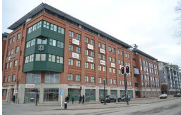
SCB-huset från nordväst med markerat indraget hörnparti och dekorativ portomfattning i formgjuten betong.
