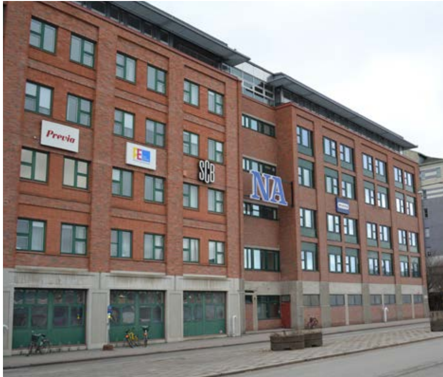
SCB-huset från Östra Bangatan. T.h i bild ursprungsbyggnaden från 1976 med bröstningar i grön aluminiumplåt. T.v. i bild påbyggnaden från 1990-talet med bröstningar i flatmurat tegel.
