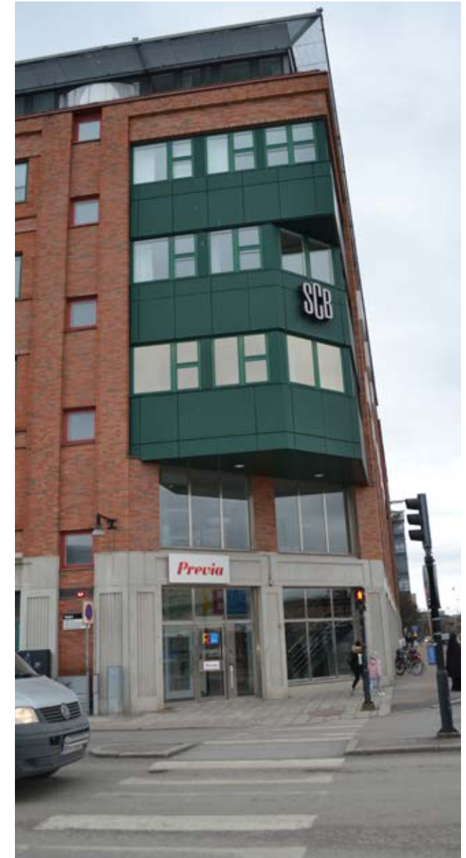
Nordvästra entrén med dekorativ portomfattning i gjutna obehandlad betong.
