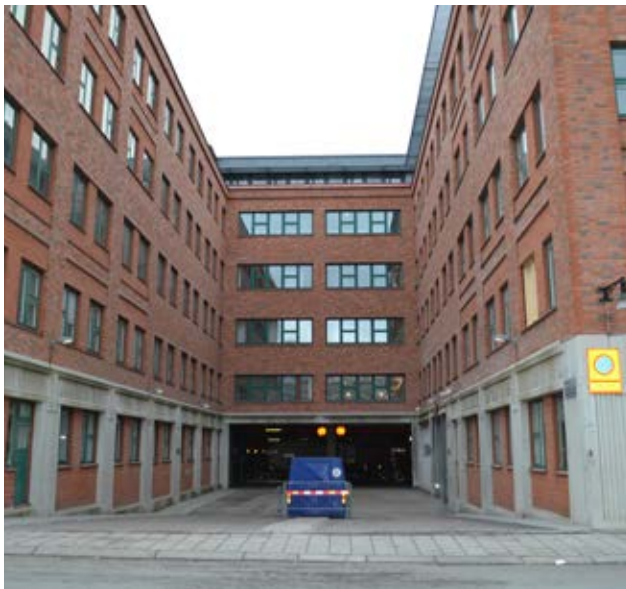
Nedfart till parkeringsgarage.
