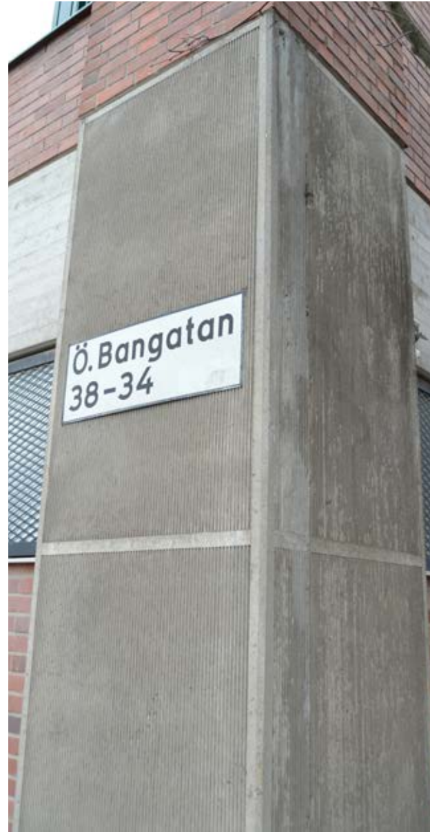
Exempel på räfflad betongbehandling som påminner om kalkstensens dekorativa behuggning.
