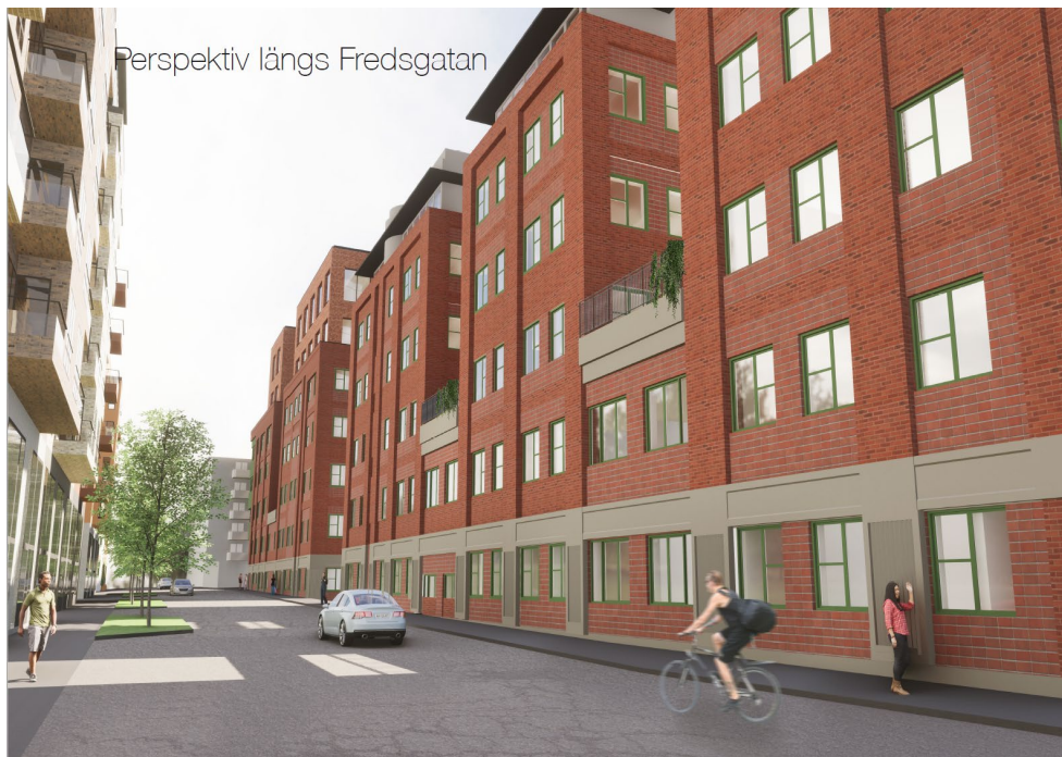
Vy längs Fredsgatan västerifrån där de två påbyggnadsvåningarna syns i den borte delen av byggnaden.
