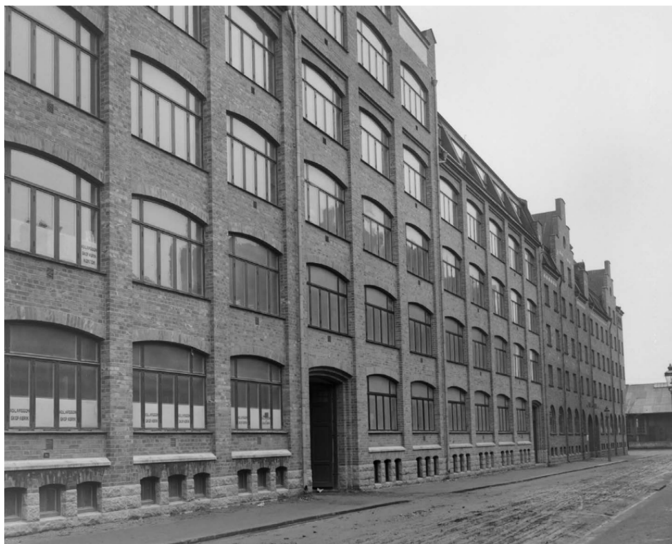
Marks skofabrik – fasad mot Klostergatan
