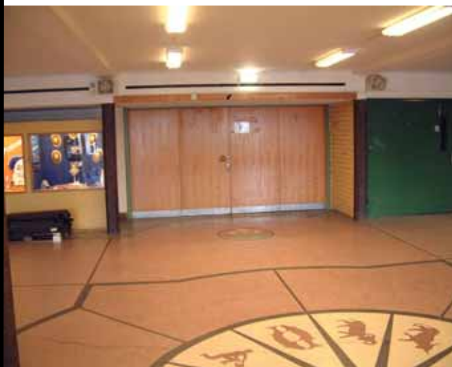
Entréhallens golv av cementmosaik med mönsterläggning
