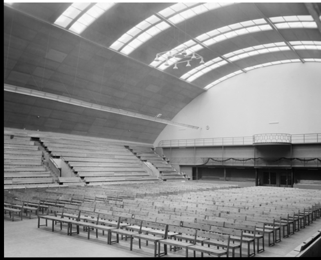
Stora hallen 1946. Partiet under balkongerna är i sitt ursprungliga skick och reklamen har ännu inte kommit in. Från lanterninerna flödar ljuset ner över golvet. Foto i Stadsarkivet.
