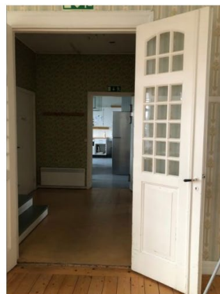
Innerdörr på bottenvåningen mot trapphallen
