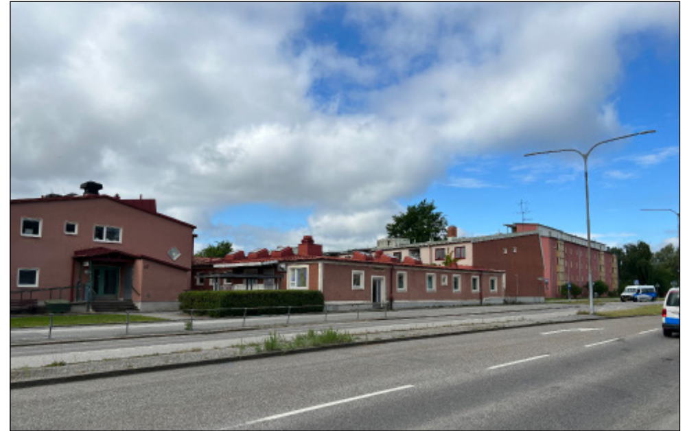
Rostahemmet har byggts ut i omgångar på 1950-talet mot Karlslundsgatan. Längan mot Sahlefeldtsgatan syns med sitt asymmetriska takfall till höger i bild. Öppenheten och den låga skalan i bebyggelsen är väsentlig för slättlandskapets karaktär.
