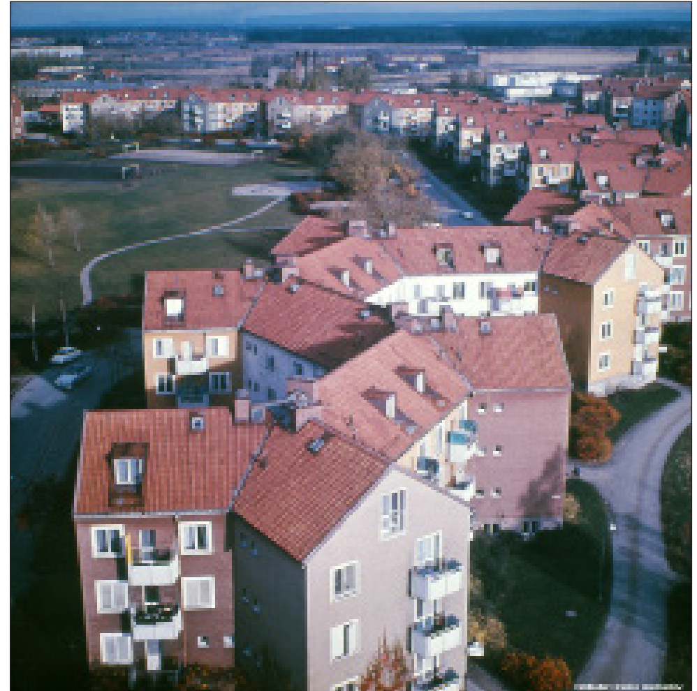
Rosta på 1960-talet efter att trafikseparering genomförts av bostadsområdet.
