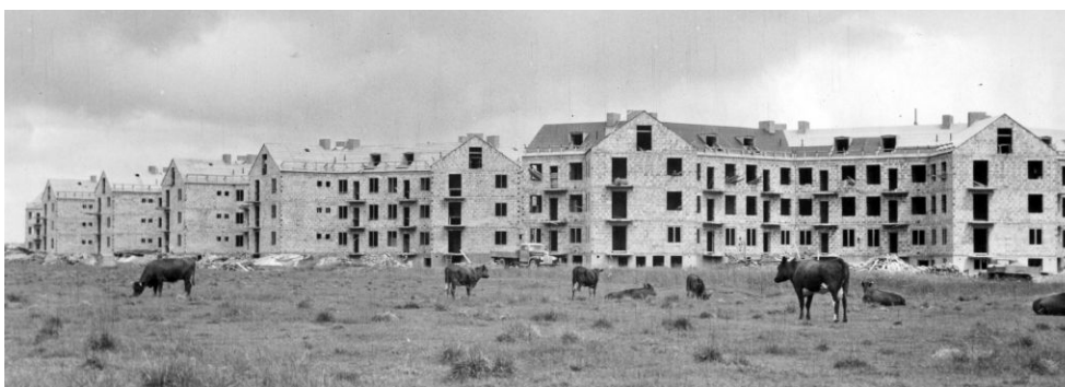
Rosta Stjärnhus under uppbyggnad.
