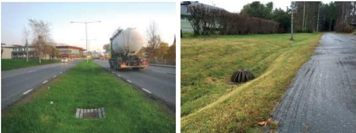
Figur 26. Två exempel på svackdiken. (Svenskt Vatten Utveckling, 2016)
