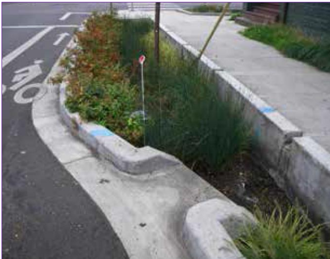
Figur 3.1B. Biofilter i anslutning till lokalgata (Uppsala Vatten)
