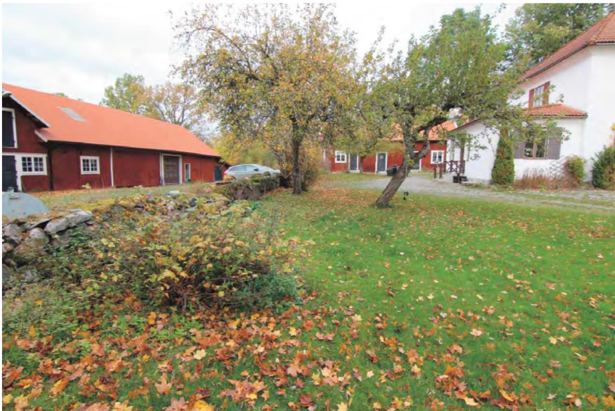
Figur 13. Björneborgs gårdscentra sett från söder. Till höger syns bostadshuset och i bakgrunden drängstugan. Till vänster syns den kallmurade stenmuren som delar bostadsområdet från ekonomibygnaderna. Vänster i bild syns även ladugården. Källa: Fredriksson arkitektkontor ab, 2022.
